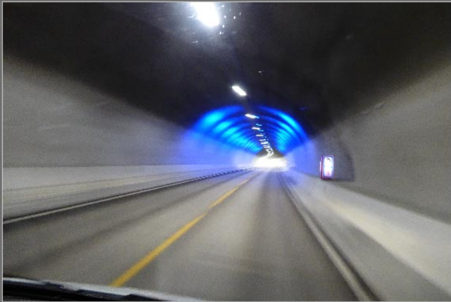
ue Beleuchtung im Tunnel zwischen Kirkenes und russischer Grenze - 02.06.
