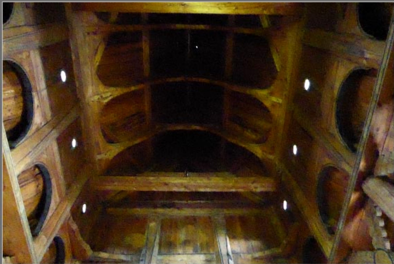
Das Dachgewölbe der Stabkirche von Borgund - 01.07.
